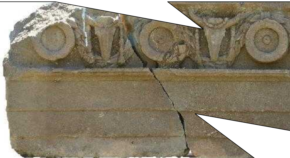
段差がくっきりと出ている
