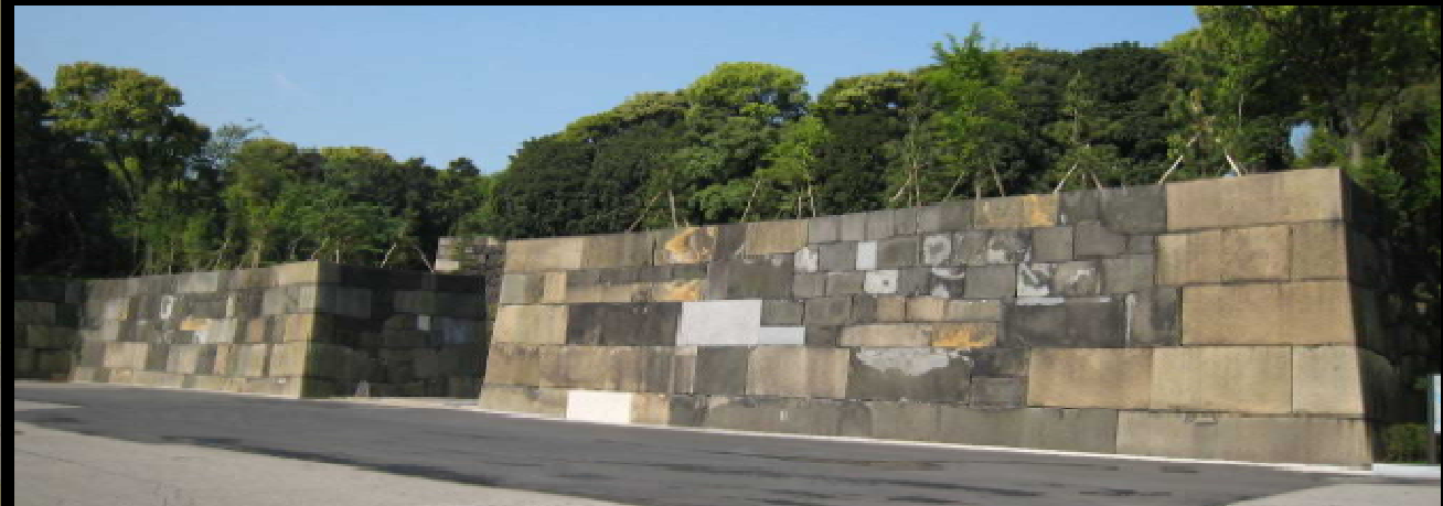
修復工事完了後の中之門全景
